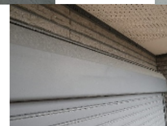
軒天 シャッターBOX
